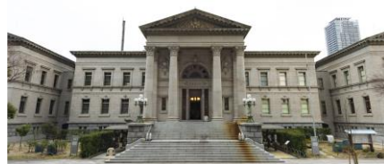
(1904年竣工 重要文化財)
