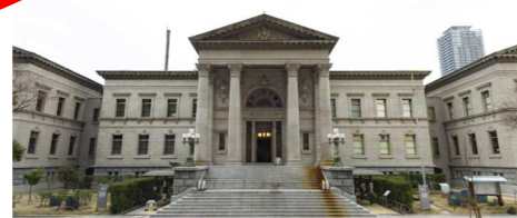
(1904年竣工 重要文化財)
